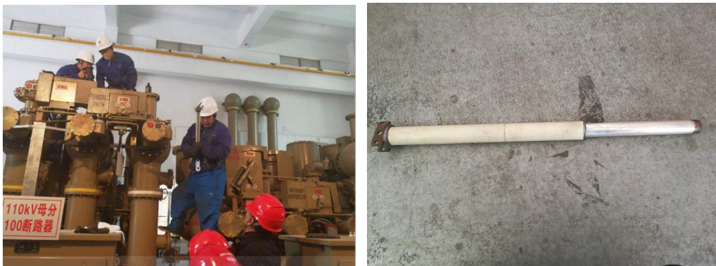
1002 刀闸现场检修照片
