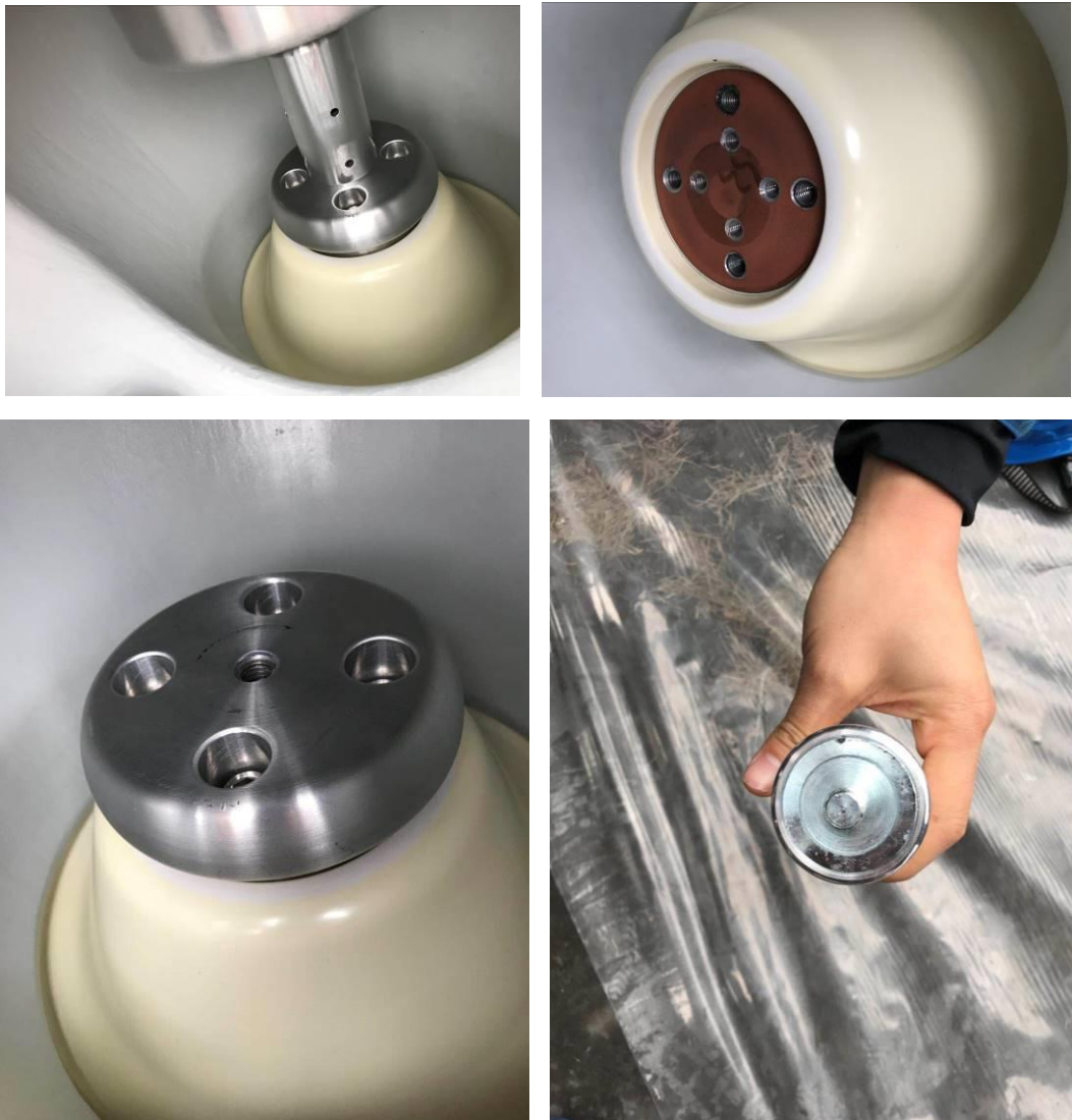
现场检修照片
